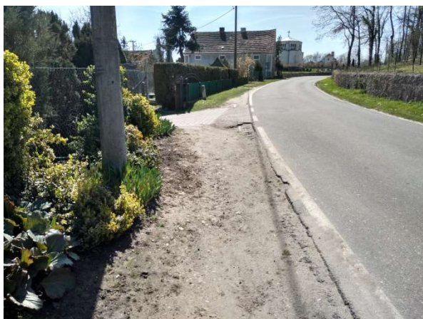
Fot. 5 Odcinek drogi nr 2085D przed bud. nr 45
