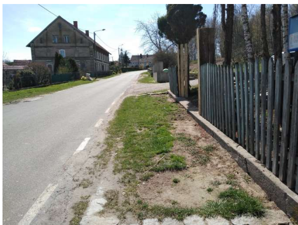
Fot. 3 Odcinek drogi nr 2085D przed bud. nr 26
