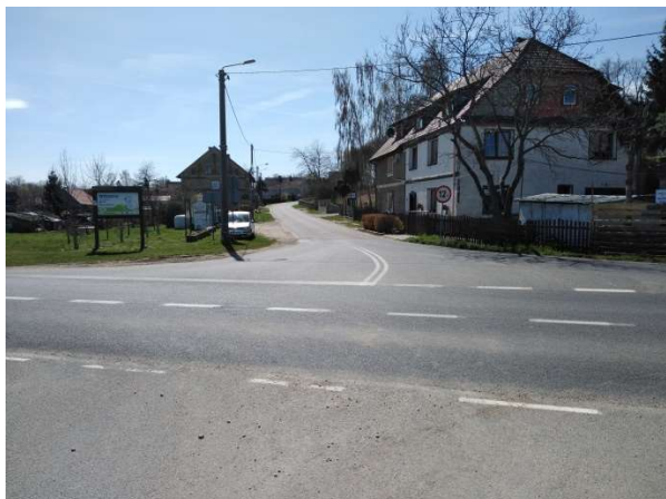
Fot. 1 Skrzyżowanie dróg nr 2085D i nr 1997D
