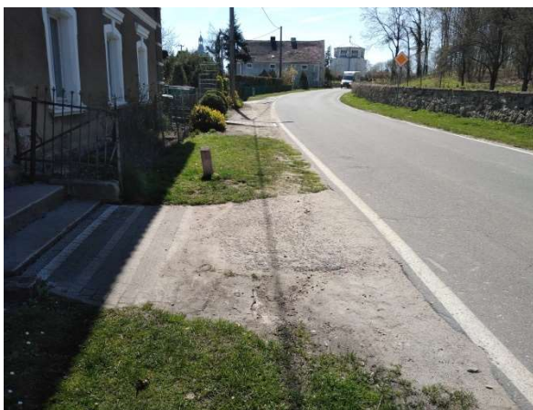
Fot. 4 Odcinek drogi nr 2085D przed bud. nr 44
